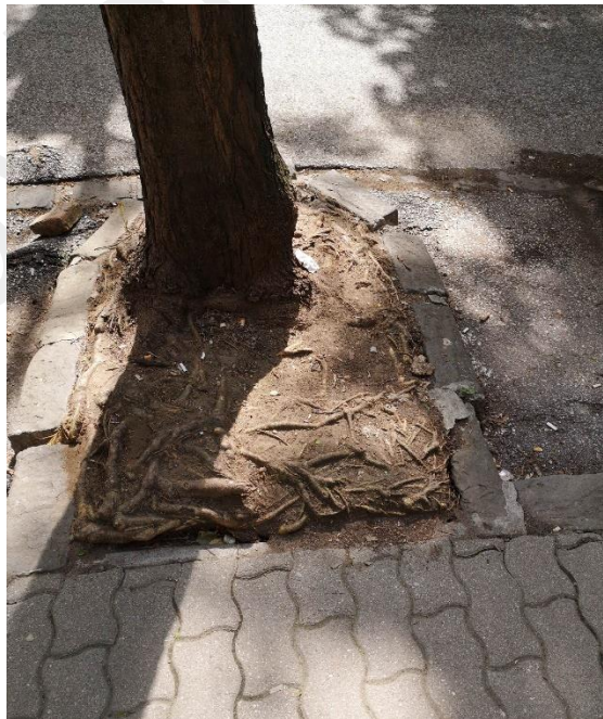
2. ábra: A gyökérélettér felszínének túlzott burkolása a budapesti Hollósy Simon utcában (saját fotó, 2023).
