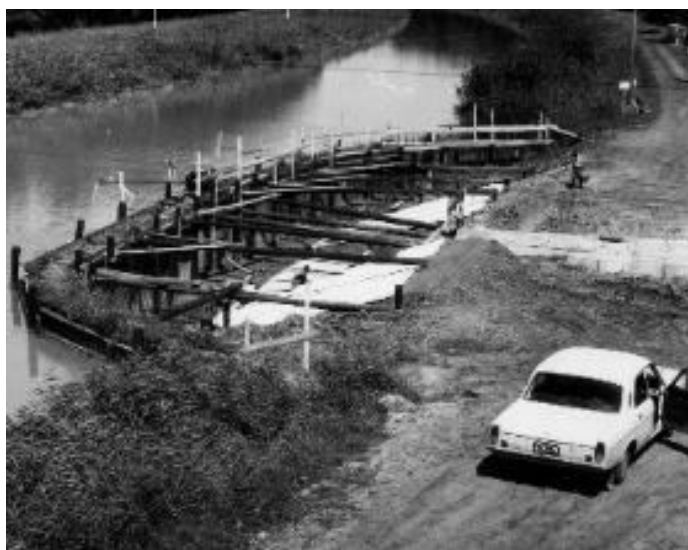
8. ábra HTVR tápcsatorna vízkiviteli pontjának építése a Keleti-főcsatornánál (Forrás: www.tococivaqua.ovf.hu )
