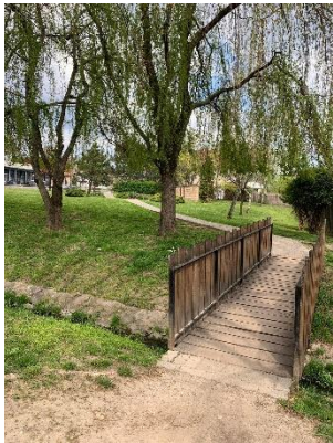
Híd a Maglódi (17.)-csatorna felett
