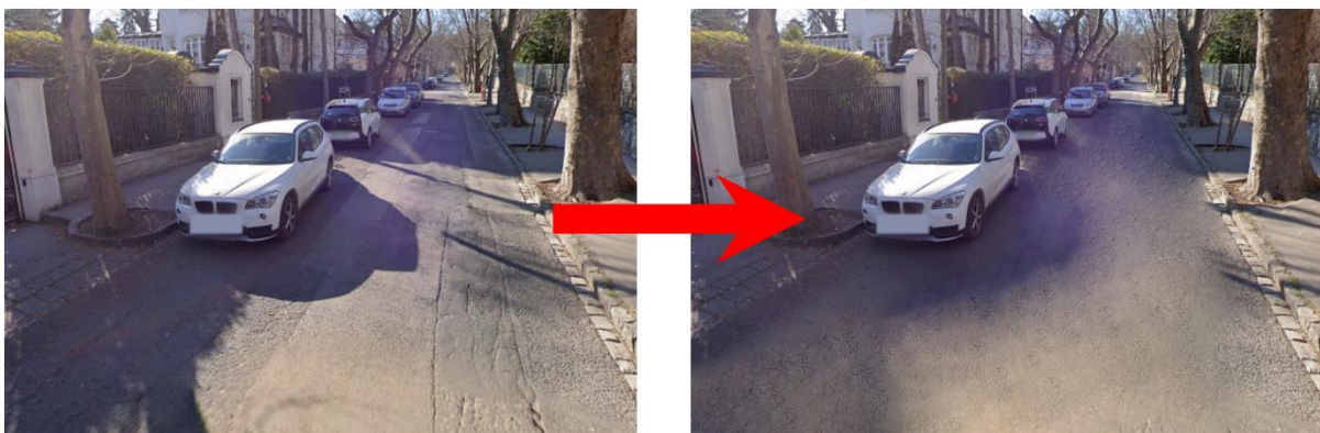
27. ábra – Útburkolati hibák javítása a Bolyai utcában
