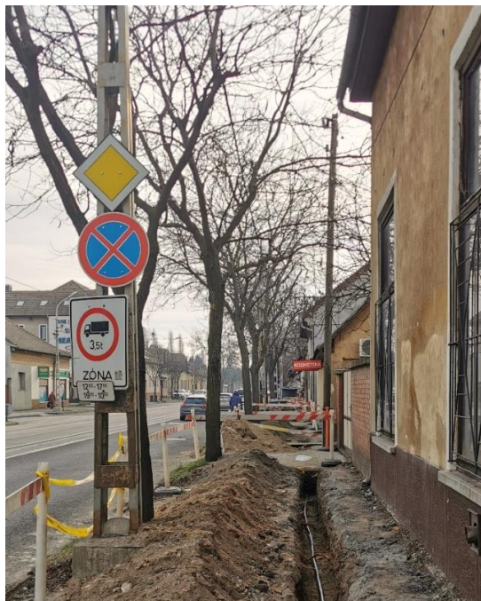
11. ábra: Nagyfeszültségű elektromos vezeték fektetése a XIX. kerületi Ady Endre út Vas Gereben-Viola utca közti szakaszán (saját felvétel, 2023).
