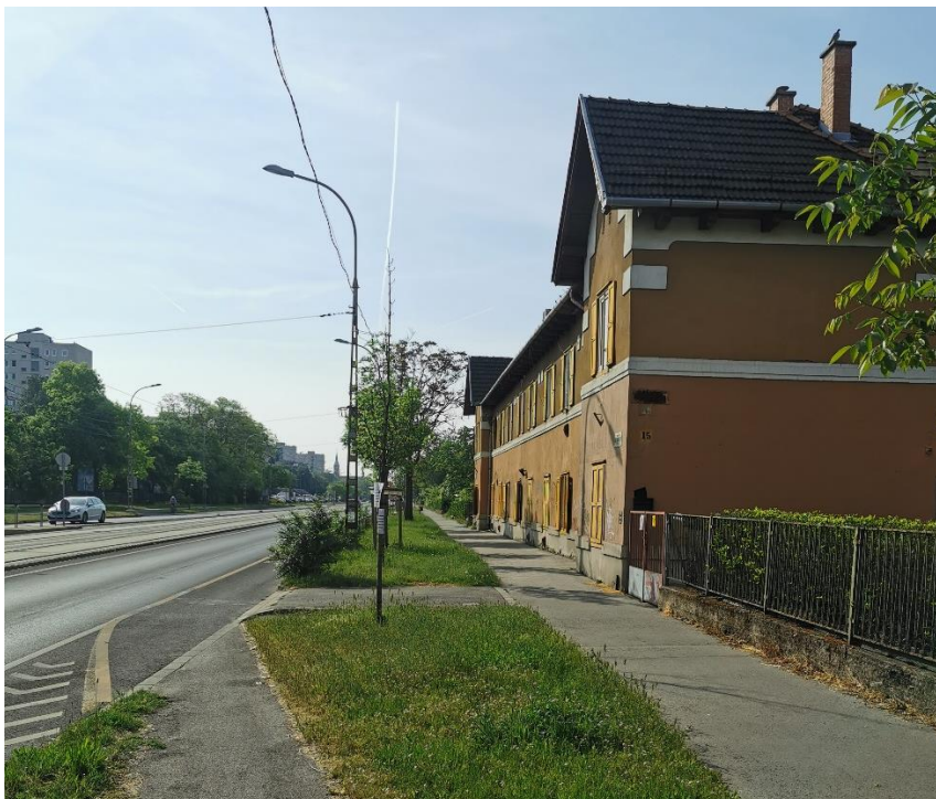
20. ábra: A XIX. kerületi Ady Endre út Határ úti metróállomás–Hunyadi utca közti szakaszának páratlan oldala részben a járdán futó kerékpársávval, előkerttel és aránylag tágas fahelyekkel (saját felvétel, 2023).
