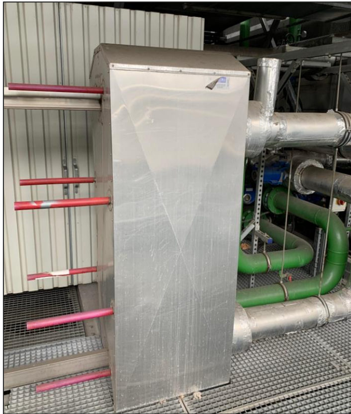
20. ábra Lemezes hőcserélő bebádogozva
