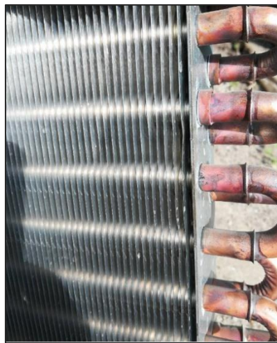
25. ábra Lamellás hőcserélő képe
