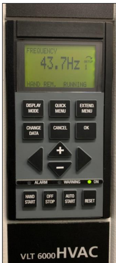
18. ábra Frekvencia váltó képe
