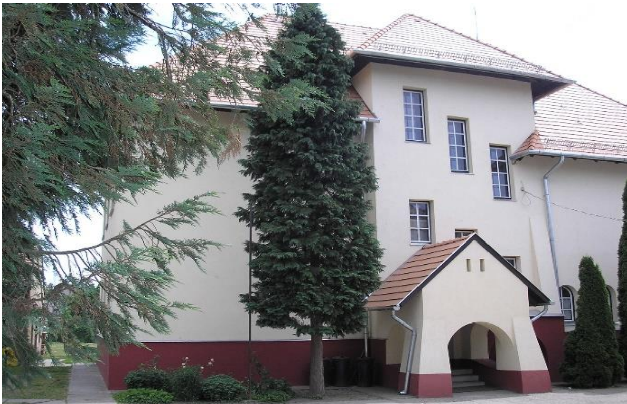
2. számú kép: Iskola épület – Zákány; Zrínyi Miklós Általános Iskola
