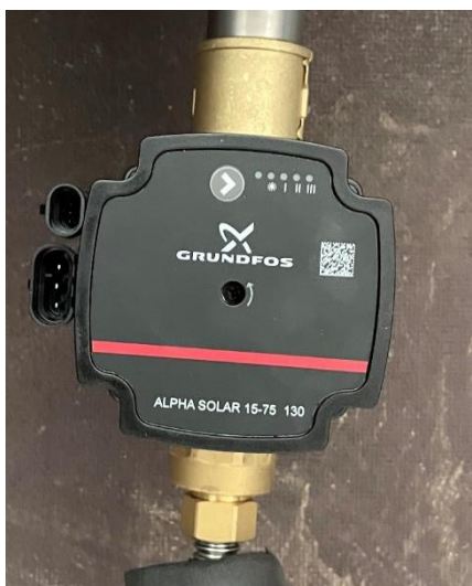
17. ábra Grundfos Alpha Solar 15-75 130 szivattyú
