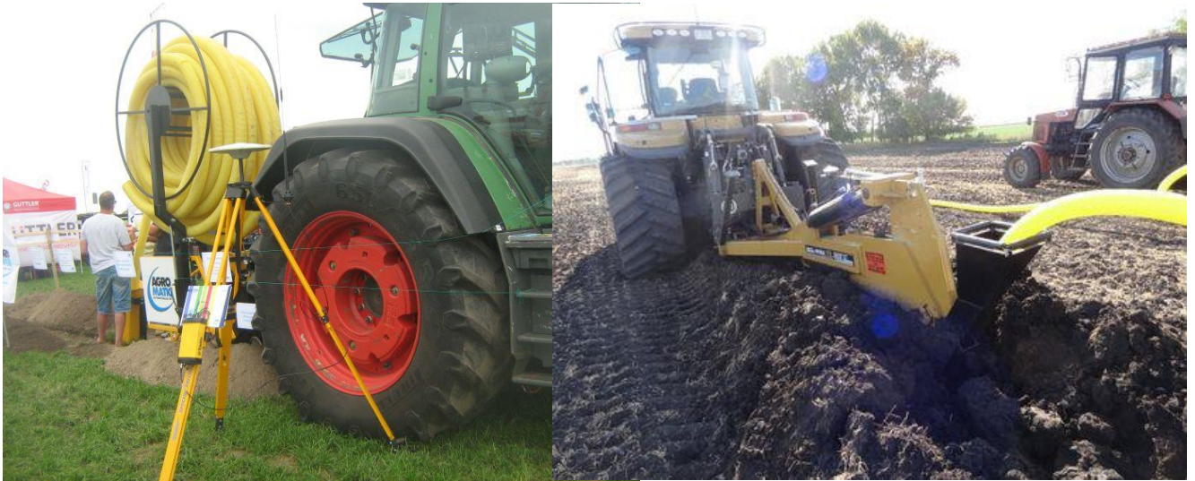
6. ábra: Dréncső fektető gépek munka közben (Forrás: https://mezohir.hu )
