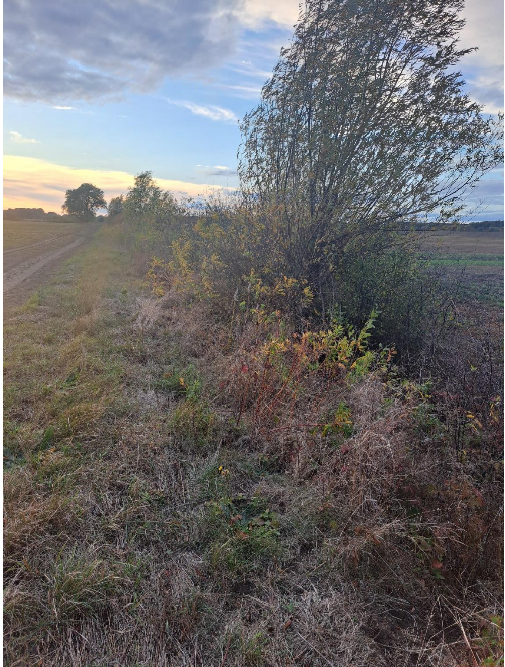
18. ábra: külterületi belvízvédelmi csatorna 112-00 „Prekup” táblánál (Saját készítésű kép)
