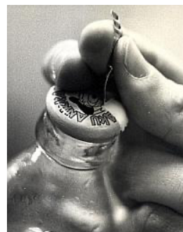
12. Ábra: Feltéphető (tear off) koronazár a 30-as évekből (forrás: Finn-Korkki Oy History )
