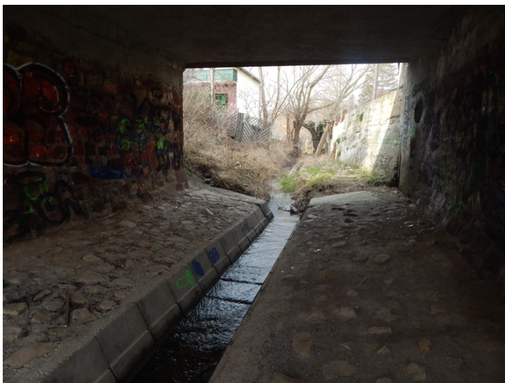
Betonzott híd alatti padka
