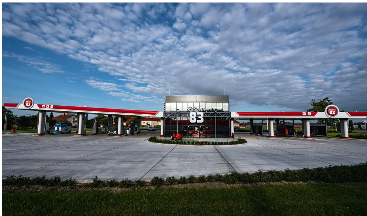
1. ábra: A benzinkút előlnézeti képe
