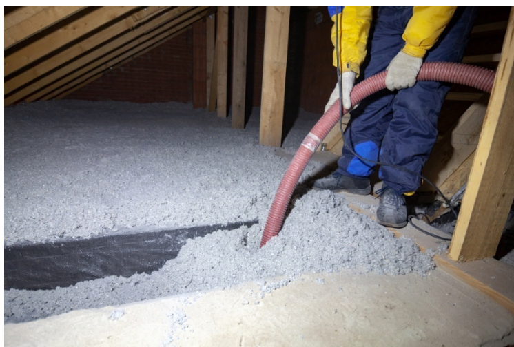
7. ábra: Cellulóz szigetelés kivitelezése (Valley Insulation, 2022)
