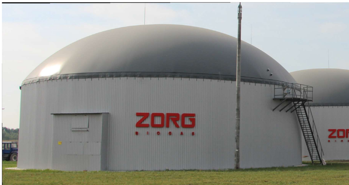
14. ábra: Zorg GmbH által tervezett és legyártott biogáz üzem [33]
