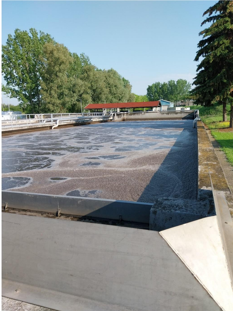
22. ábra: Levegőztető medence
