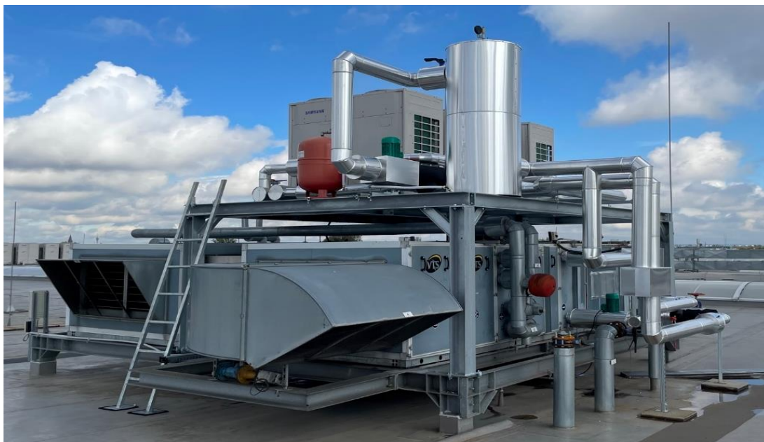
4.5. ábra korszerűsítés utáni légkezelő egység hőszivattyúkkal szerelve [saját fotó]
