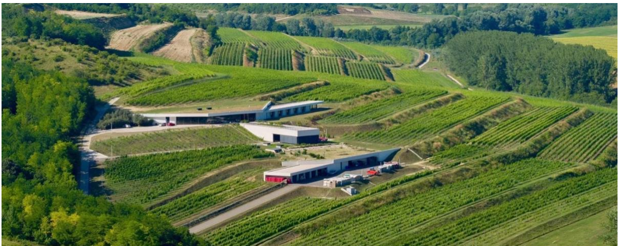
8. ábra - Lajver Borászat épülete és a teraszos szőlőültetvények Forrás: Bord Építészeti Stúdió weblapja
