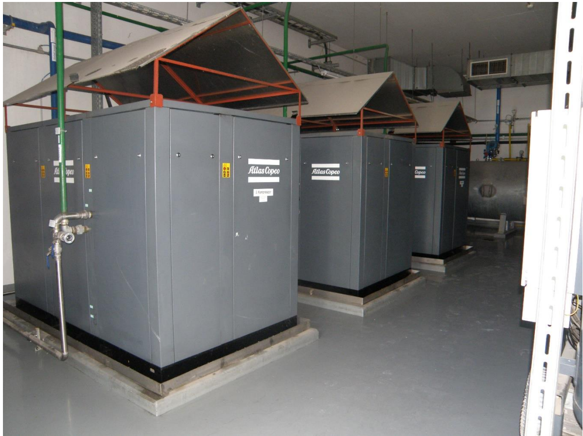
8. A jelenleg üzemelő kompresszorok [Forrás: saját kutatás alapján saját szerkesztés]
