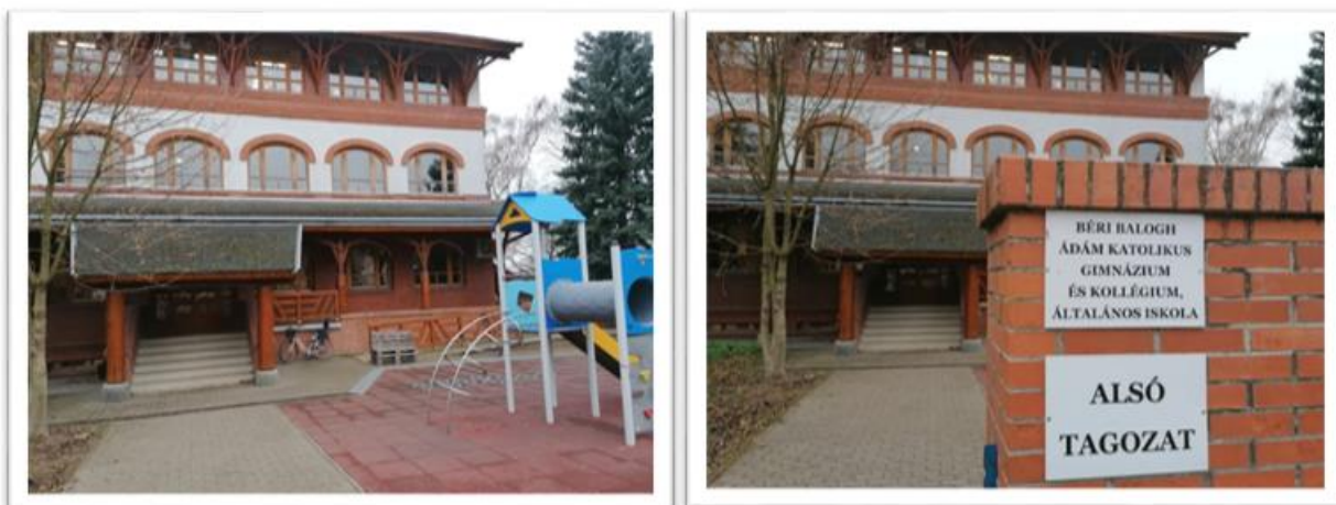
7. ábra Béri Balogh Ádám Katolikus Általános Iskola jelenlegi telephelye
