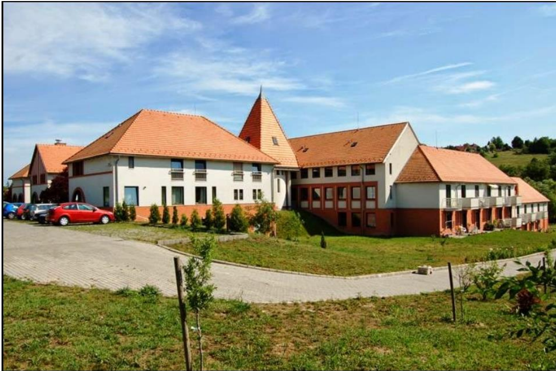
2. ábra: Az idősothton épületének homlokzati képe [ GoogleMaps ]
