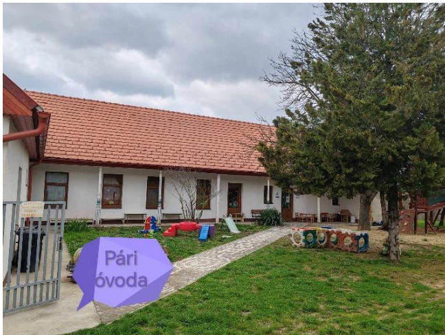
6. kép: Pári óvoda épülete (saját készítésű fotó)
