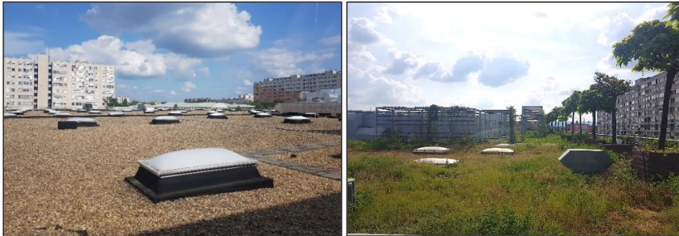
23. ábra: IKEA régi épület szárnya kavics borítással (bal) és az új szárny zöldtetővel (jobb) (saját készítésű fotó)
