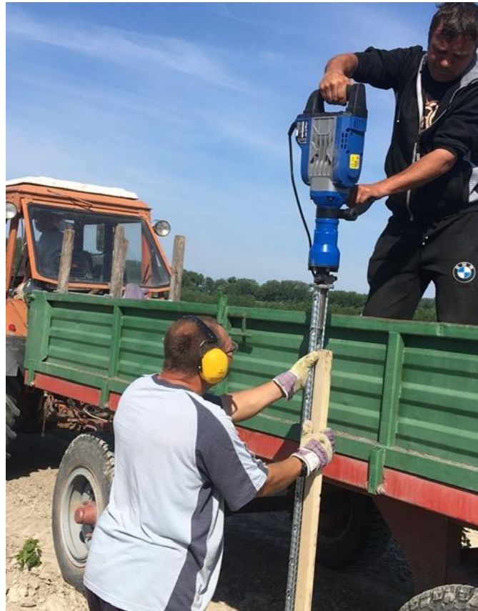
9. ábra Egy oszlop beverése (saját kép)
