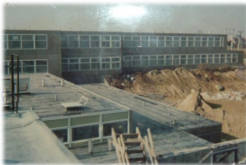
(A Kecelhegyi Általános Iskola, Speciális Szakiskola és Diákotthon építkezési munkálatai 1986) 11
