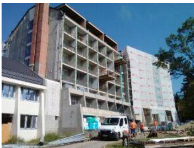
2. Kép A hotel felújítása (Forrás: Avar Hotel saját anyaga)
