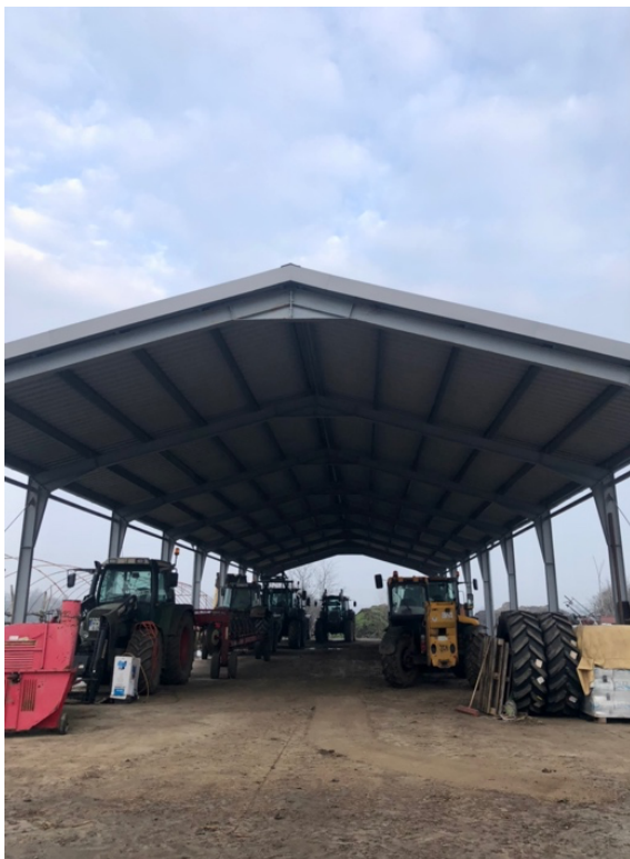
17. ábra Gépcsarnok a telephelyen forrás: saját kép
