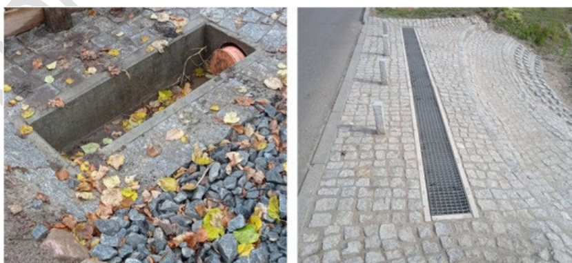
16. ábra: Példák ülepítő berendezésekre Gdansk-ban 76 (M. Kasprzyk fotó) (Forrás: https://www.sciencedirect.com/science/article/pii/S0048969722025839 )
