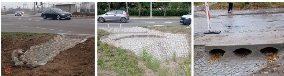
15. ábra: A gdański esőkertekből származó példák beömlőkre 76 (fotó: M. Kasprzyk) (Forrás: https://www.sciencedirect.com/science/article/pii/S0048969722025839 )
