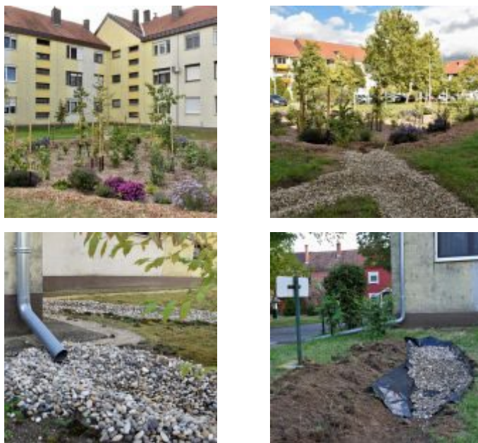
13. ábra: Az esőkert létrehozásának lépései (Forrás: Zöld küldetés honlap 2021.)
