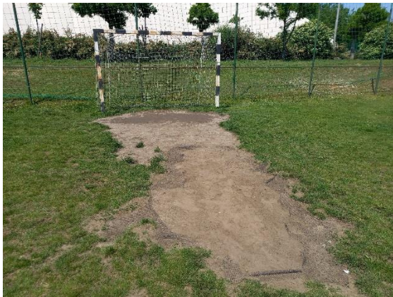
21. Melléklet Bókay-kert élőfüves futballpálya elhasználódott burkolata és kopott berendezése (Forrás: Saját, 2023)
