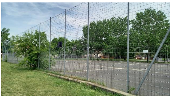
15. Melléklet Bartók Lajos utcai sportpálya körüli kerítés (Forrás: Saját, 2024)
