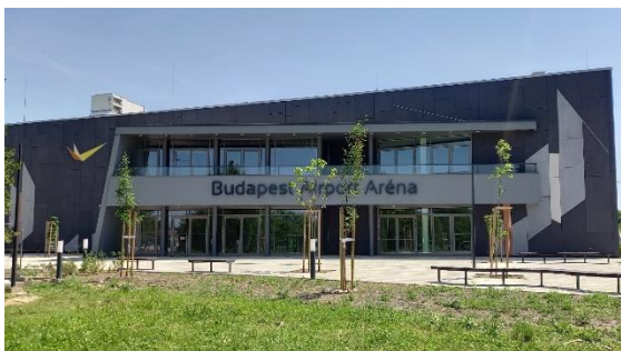
31. Melléklet BUD Aréna épülete (Forrás: Saját, 2023)
