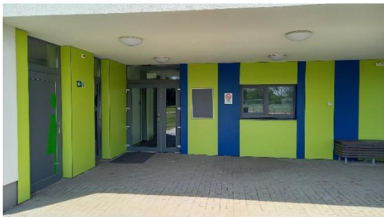
38. Melléklet Gerely utcai sportterület főépület bejárata és mosdók (Forrás: Saját, 2023)
