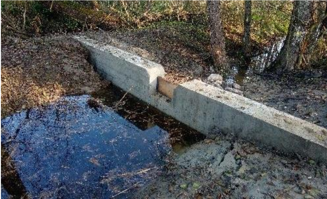
1. melléklet Felvízmegtartó műtárgy a Lankóc i -erdőben. Forrás: WWF
