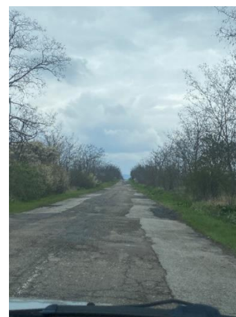
34. ábra: Novaj felé tartó útszakasz forrás: saját fotó
