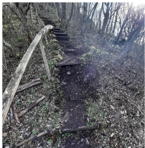
12.Melléklet: Tanösvény hiányzó lépcsőfoka, talajerózió –Saját készítésű fotó
