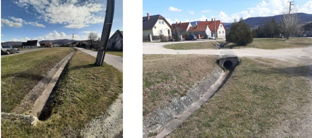
Hegyesd településén látható, víz nélküli burkolt csatornahálózat betonelemei – Kép saját készítés
