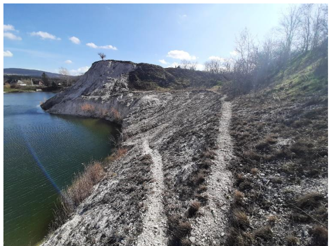
14.Melléklet: Kitaposott csúszásveszélyes ösvények a merdek dolomit falakon – Saját készítésű fotó
