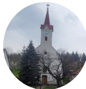
20. ábra Evangélikus templom; saját fénykép
