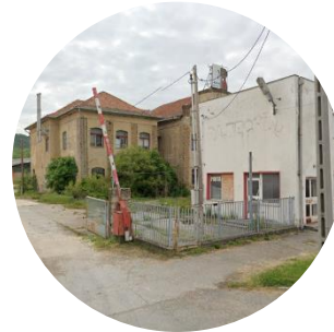
77. ábra Régi gyárépület bejárata; saját fénykép
