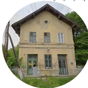
76. ábra Romhányi vasútállomás épülete; saját fénykép
