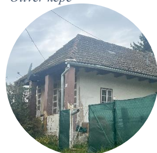
120. ábra Népi tornácos ház; saját fénykép
