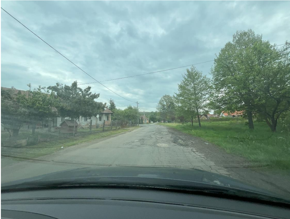
6. melléklet Út állapota Felsőpetény; saját fénykép
