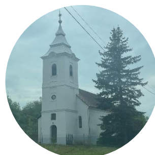
48. ábra Felsőpetényi Evangélikus Gyülekezet épülete; saját fénykép
