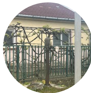
109. ábra Norton-típusú régi közkút; saját fénykép
