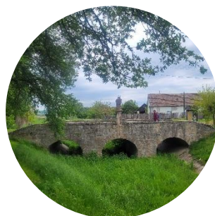
74. ábra 18. századi háromlyukú kőhíd; saját fénykép
