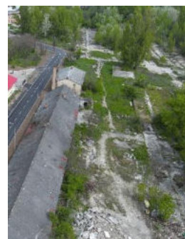
20. kép: Betonelem gyár területe forrás: drone Tatabánya
