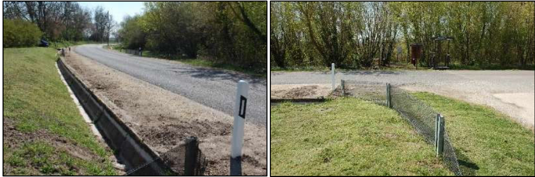
21. és 22. fotók: Békaterelő műszaki berendezések (saját fotók)
