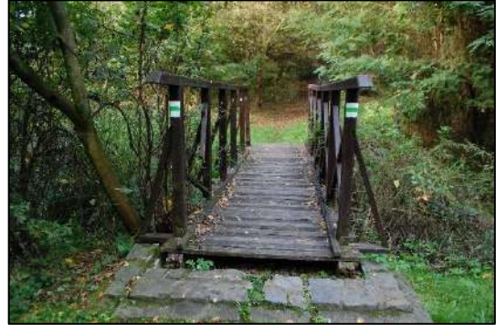
3. fotó: Híd a patak felett a forrásnál (saját fotó)
