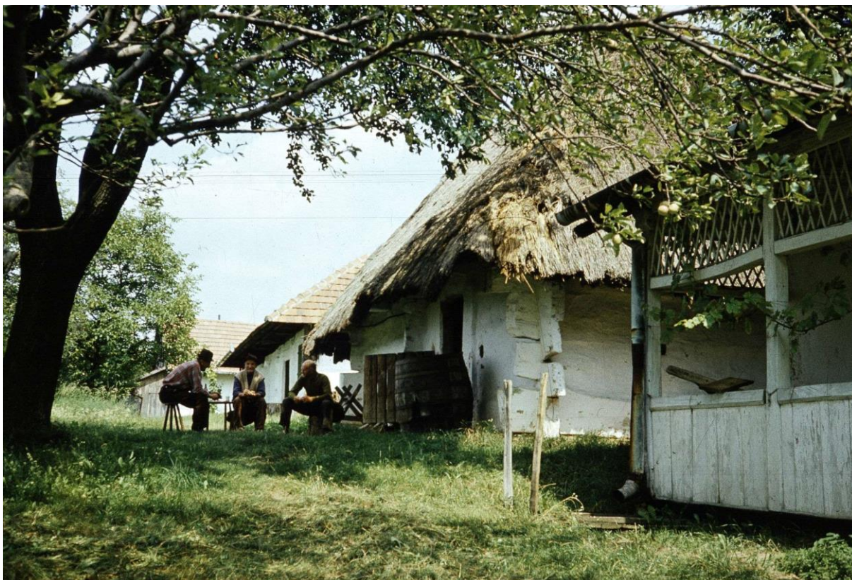
12. ábra: Karóköz tömés- és boronapincék a Pusztaszentlászlói Újhegyen. (fényképezte: Loszmann Ágnes)
