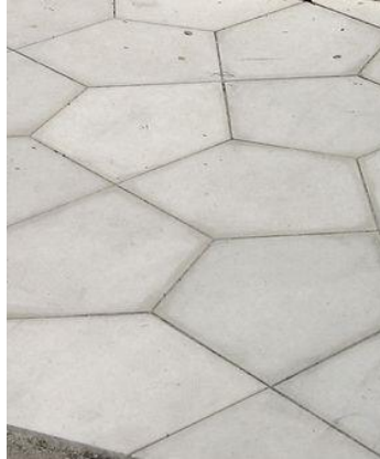
Öntött beton burkolat dilatálva 39
