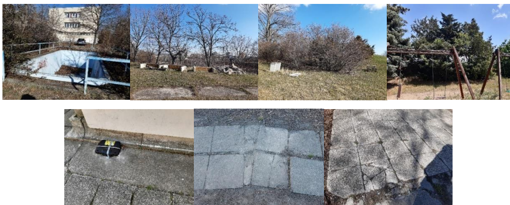
25. ábra, Berendezési tárgyak, burkolatok (forrás: saját képek)
