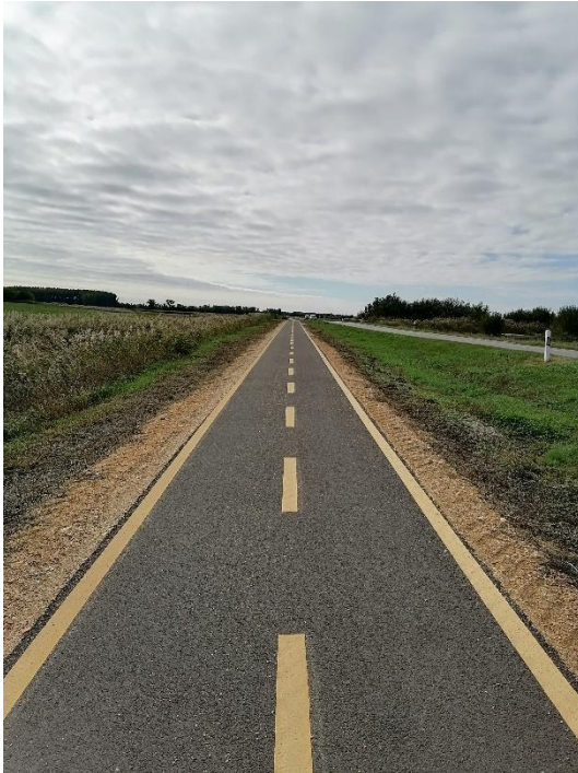
47. ábra: Fátlan kerékpárútszakasz (Forrás: saját fotó)
