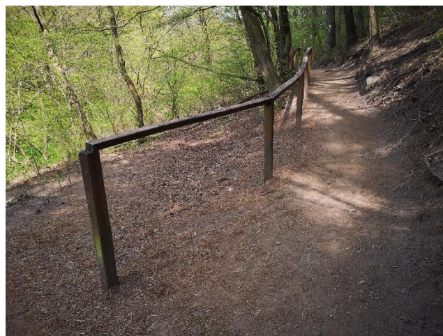
6. számú fénykép: A korábban leszakadt útszakasz lekerítése
