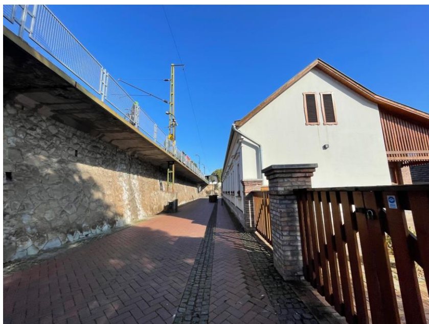
20. A vasúti vasbeton műtárgy vizuális hatása (forrás: saját kép)
