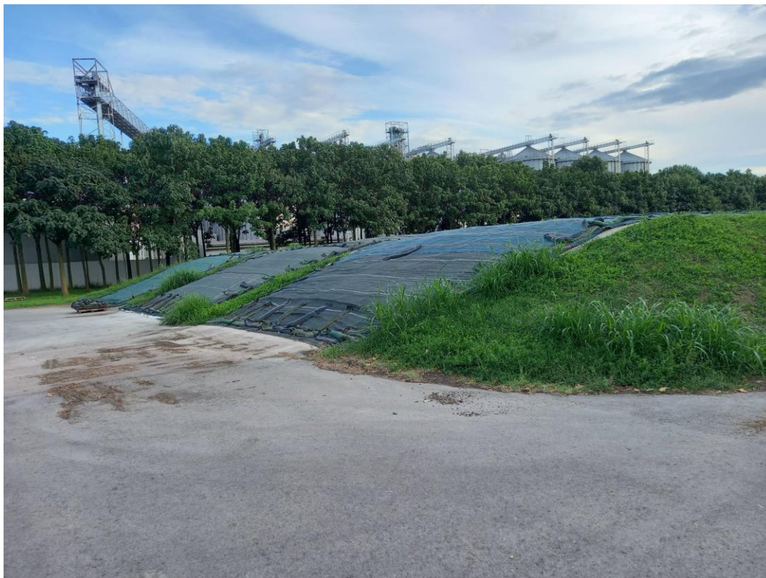
10. kép Beton silóterek
