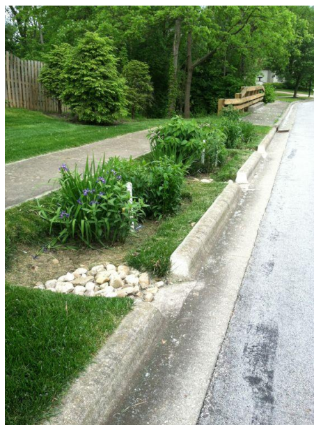
59. ábra: Gyepes esőkert szikkasztás (forrás: http17 )
