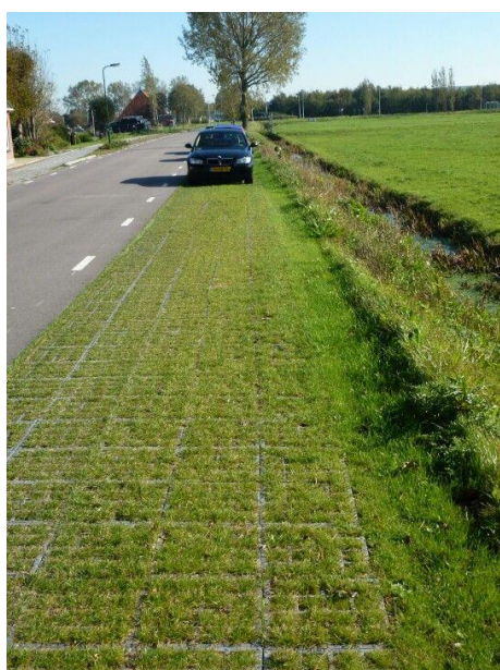
60. ábra: Gyephézagos parkoló kialakítása (forrást: http17 )
