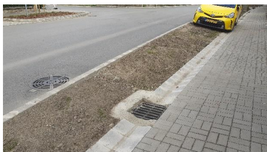
62. ábra: Víznyelő szemek kifejezésének javaslata (fotó a Duna útról) (forrás saját kép)
