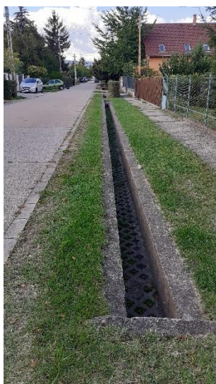
66. ábra: javaslat nyílt árokban elvezetésre és szikkasztásra (fotó a Mátyás utcából) (forrás: saját fotó)
