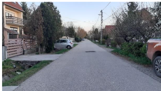
52. ábra: Otthon utca vízelvezetése (forrás: saját fotó)
