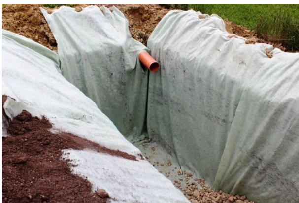
72. ábra: Javaslat felszín alatti szikkasztóakna kialakítására (forrás: http20 )
