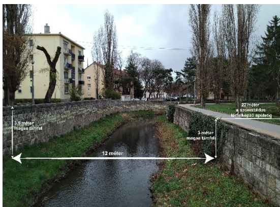
49. ábra: 'G' szakasz metszete (saját készítésű ábra)
