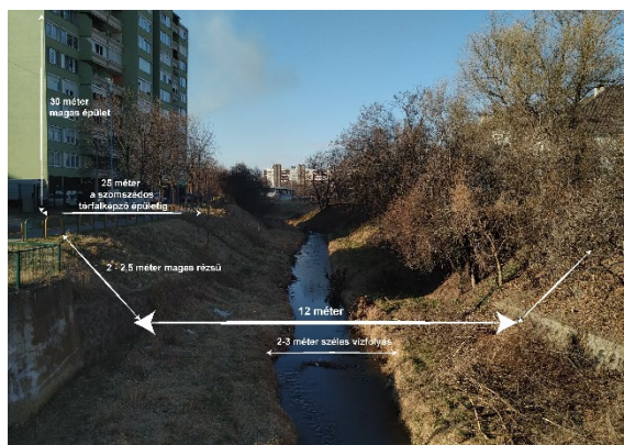
41. ábra: 'B' szakasz metszete (saját készítésű ábra)
