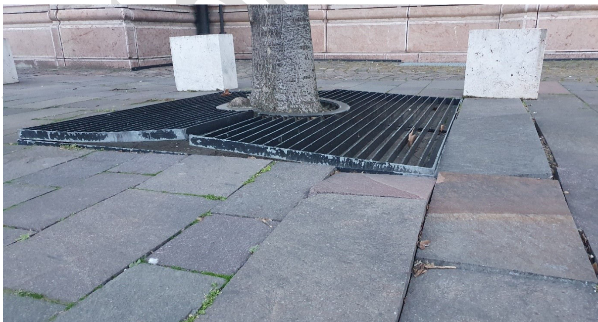
17. ábra: Felynomódott faveremrác és térburkolat (saját felvétel, 2023)
