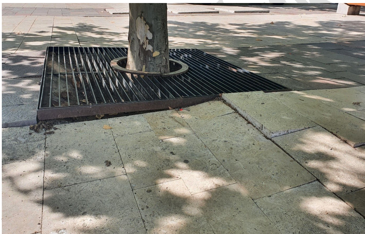
18. ábra: Felnyomódott faveremrács és térburkolat (saját felvétel, 2022)
