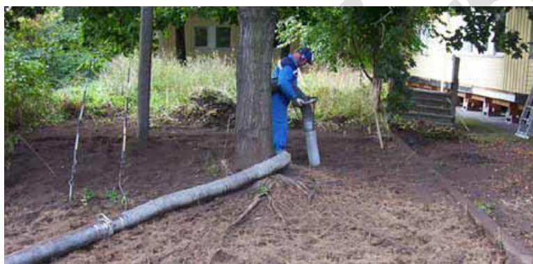
8. ábra: Gyökérfeltárás végzése földszívóval (fotó: Örjan Stal)
