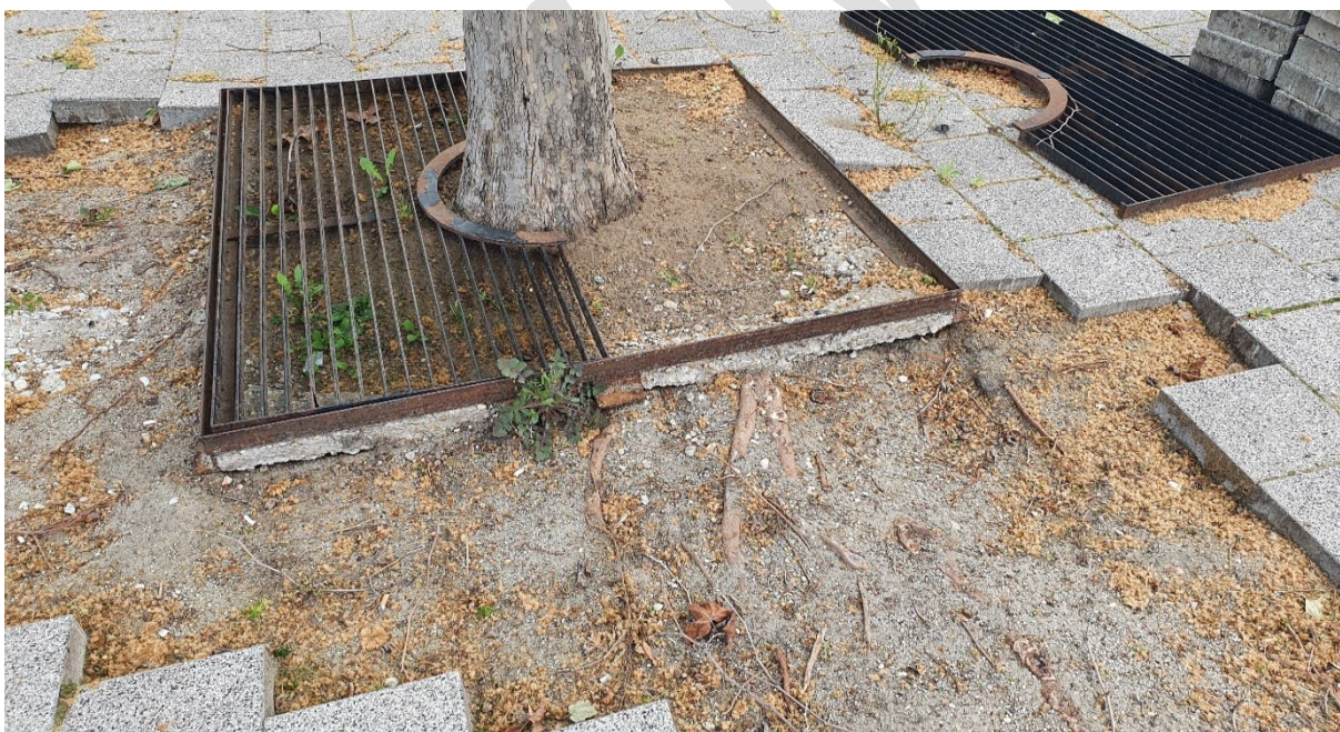
21. ábra: Gyökerek által felyomott burkolat feltárás közben (saját felvétel, 2022)
