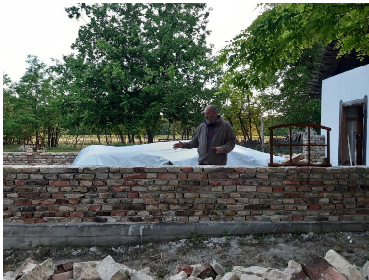
7. ábra: melléképület bővítése
