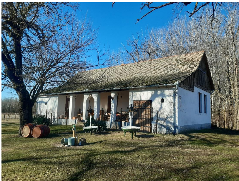
3. ábra: A restaurált főépület
