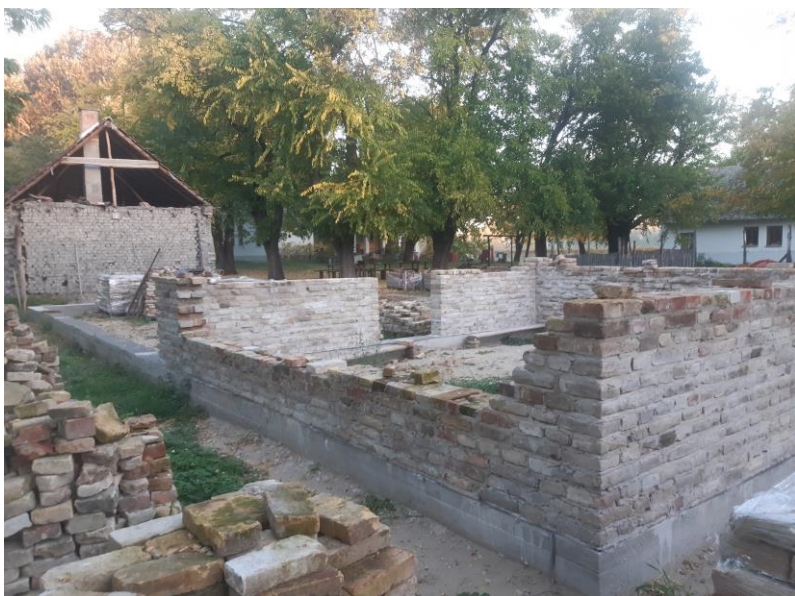
11. ábra: Az egykori mezőgazdasági épület újjáépítése
