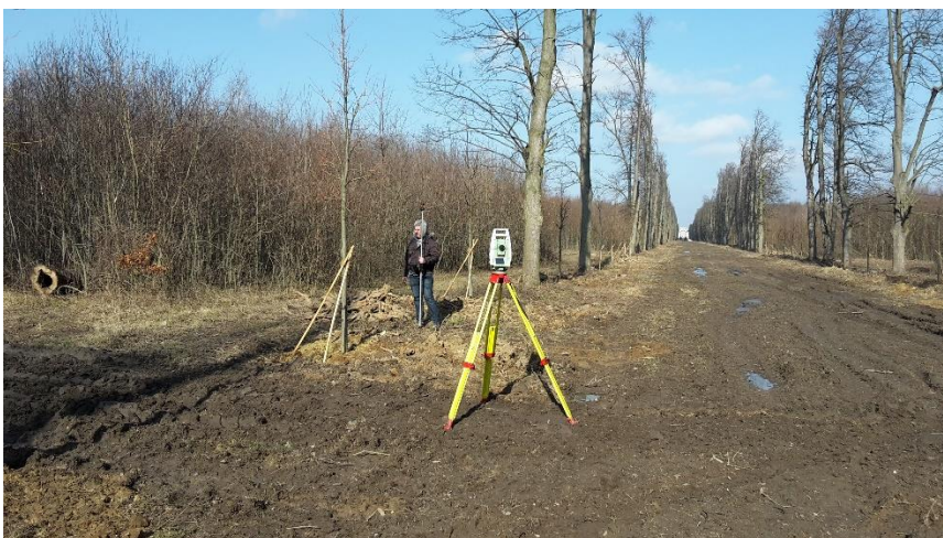
2/2. sz. fotó: A 2011-2015 közötti komplex fasor rekonstrukció, beültetett fák (2311 db) és kitűzésük, 2014. október – fotó: Szabó Gábor
