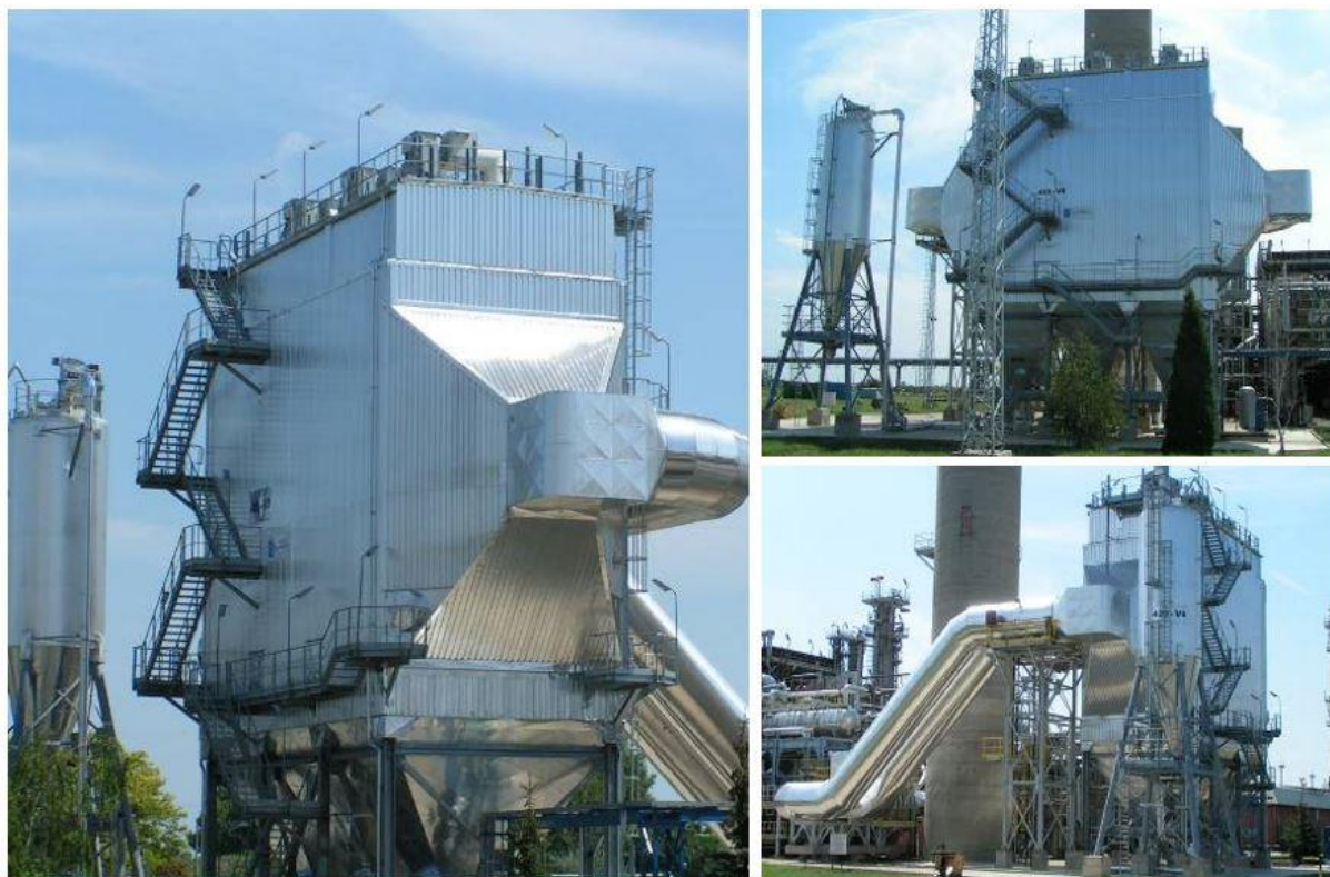
12. ábra: Elektrosztatikus porleválasztó [11]
