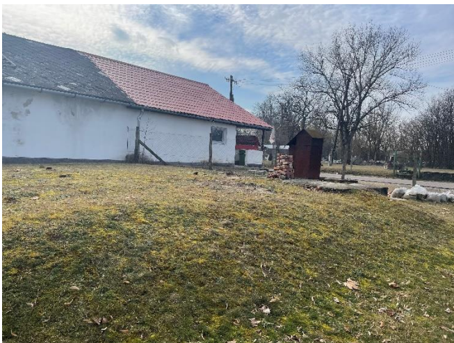
10. ábra Szádfalas megtámasztás javasolt az épület közelsége miatt, továbbá kerítés bontás is szükséges (Saját kép)
