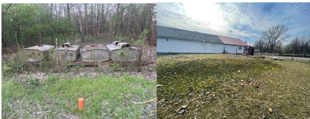
3. ábra A II. számú Objektumban 4 db, egymás mellé fektetett, egyenként kb. 1 m 3 térfogatú fekvőhengeres tartály, valamint az I. számú Objektum föld alatti HTO tartályának területe (Saját készítésű kép)
