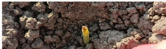
8. sz. ábra: Keletkezett károk (Forrás: Saját kép)
