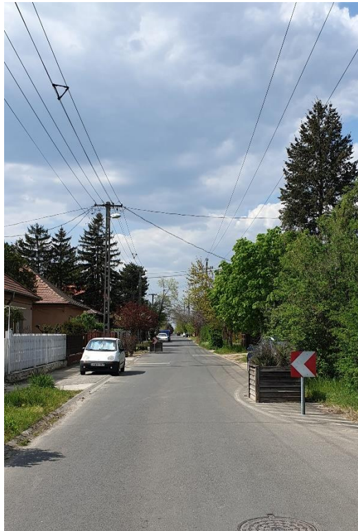
2. ábra: Útkeresztmetszet szűkítő műtárgy (Saját fénykép)
