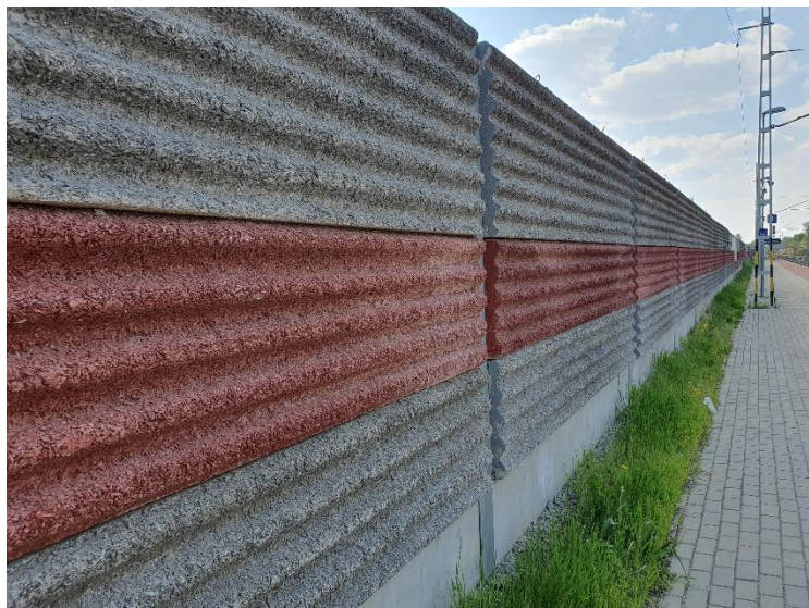
4. ábra: Zajvédelemi fal (Saját fénykép)
