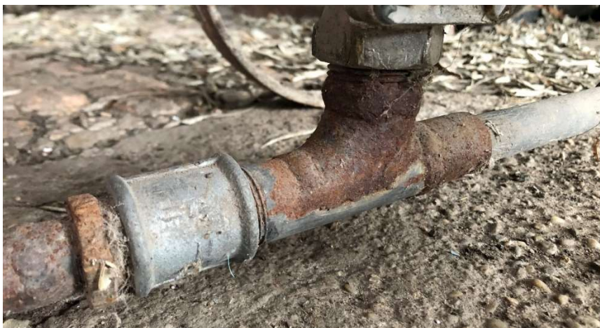
8. ábra "T" idom kiváltására készült, hegesztett idom
