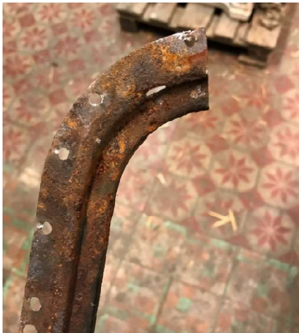
12. ábra Eltávolított korrodált lemezalkatrész
